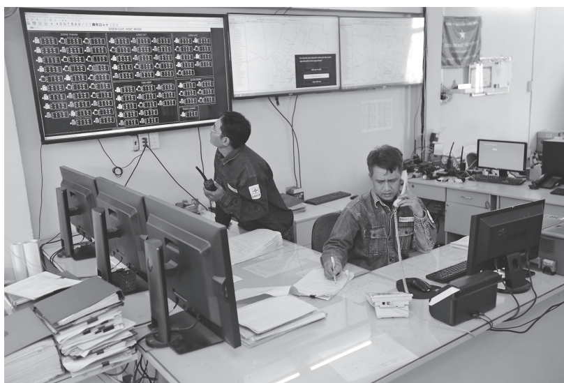
Nhân viên Công ty Điện lực Hóc Môn trực thuộc Tổng Công ty Điện lực TP.HCM trực vận hành. Ảnh: ĐL.
